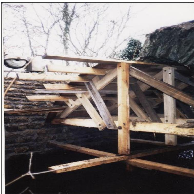
Pour l'exemple, nous prendrons la reconstruction du pont de la fonderie dans son état d'origine (cotes, matériaux et forme). Les photos ci-contre vous montreront le gabarit démontable qu'il avait imaginé et réalisé pour aboutir à une conformité parfaite. Chacun peut juger du résultat! Encore merci Charles.
