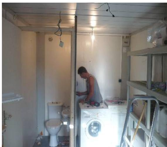
Afin d'améliorer les conditions phoniques du réfectoire et ses performances en matière d'isolation thermique, il a été réalisé la pose d'un plafond suspendu acoustique et thermique. Les quatre fenêtres et la porte d'entrée à l'arrière de la cantine ont été remplacées par des fenêtres PVC double vitrage.
